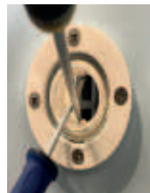
Tag två mejslar för att få bort kulans säte innanför ramen
