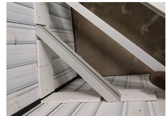
1. Montera en forexlist 60x18x2000 (A) 160mm under lagunväggens överkant (se punkt 1). Använd träskruv 5x60 C4. Skruva fast listen i lederna mellan aqvissponten mot ytterväggen.
