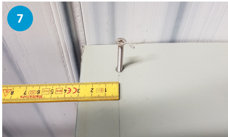
7. Mät in 30 mm från lagunkanten för att fästa skruven i alu-listen som ligger under lagunskivan, avstånd mellan skruvarna cc 300 mm. Använd skruv 4,0x32 längs med kanterna, cc 150 i forexplattan (C).
