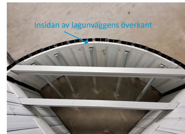
1. Montera en forexlist 60x18x2000 (A) 160mm under lagunväggens överkant (se punkt 1). Använd träskruv 5x60 C4. Skruva fast listen i lederna mellan aqvissponten mot ytterväggen.
