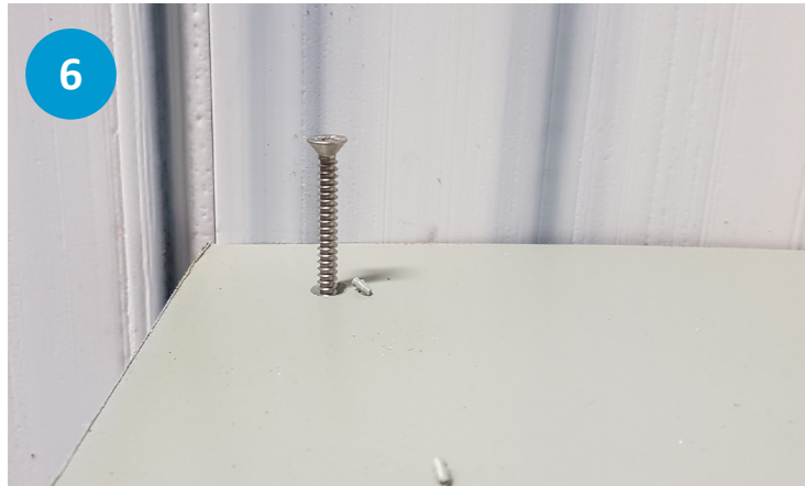
6. Fäst lagunskivan med självborrande Vingskruv i alulist och alubalk
