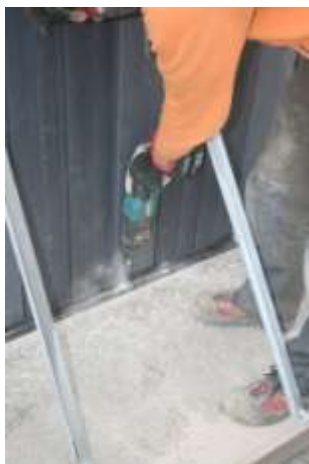
Borra med borrhammare 6 mm borrh igenom konsolens fästplatta
